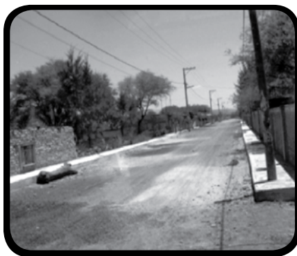
Electrificación en León Cárdenas Michoacán. Club León Cárdenas (HTA), Chicago
