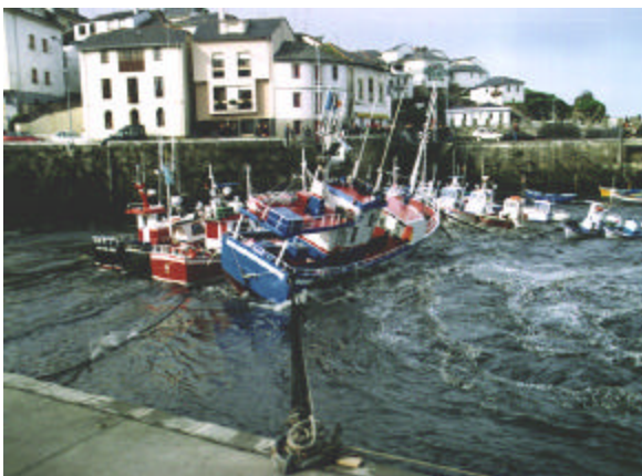
Figura 2.- Ensayos de resonancia (ondas largas). Puerto Vega (Asturias).
