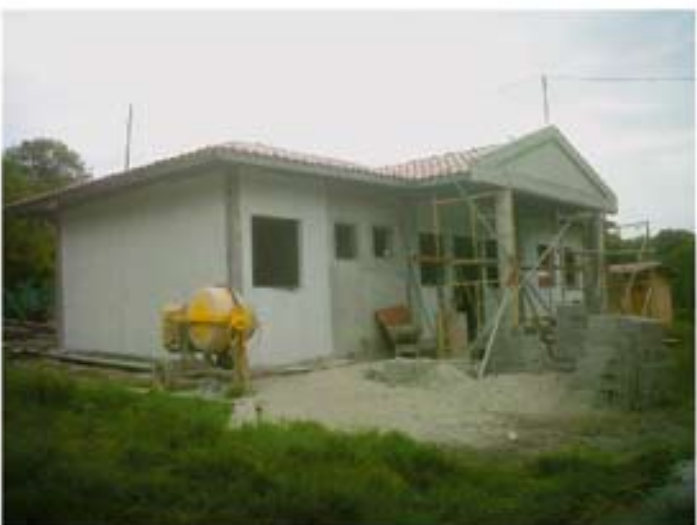
Construcción del juzgado de Pocrí en la provincia de Los Santos.
