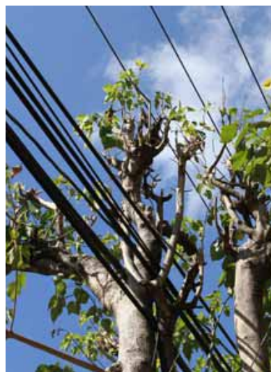
“Poda” bajo cableado
