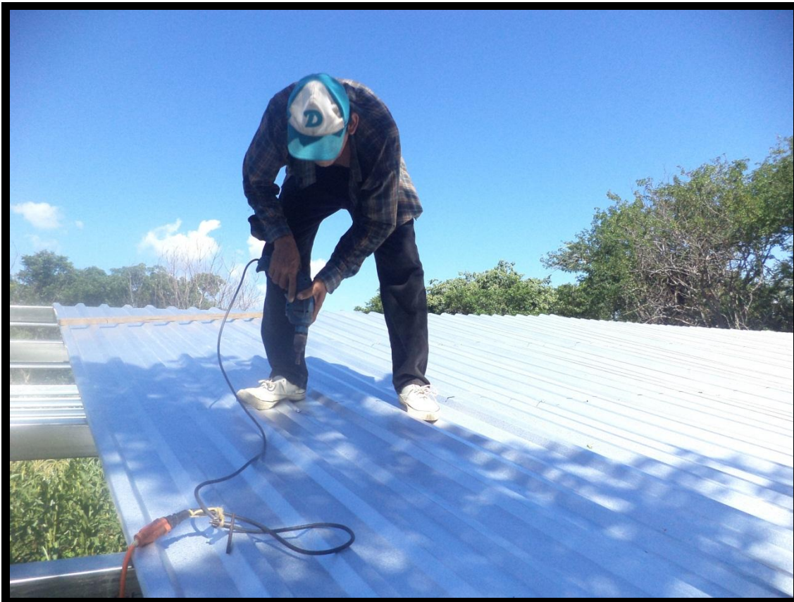
Foto 8. Construcción de microindustria en La Comunidad del Espino.
