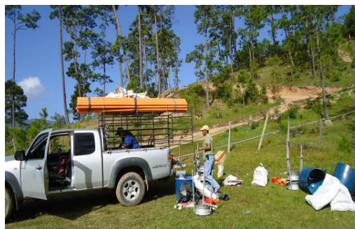
Traslado de materiales y equipo a la comunidad de Chuabaj.
