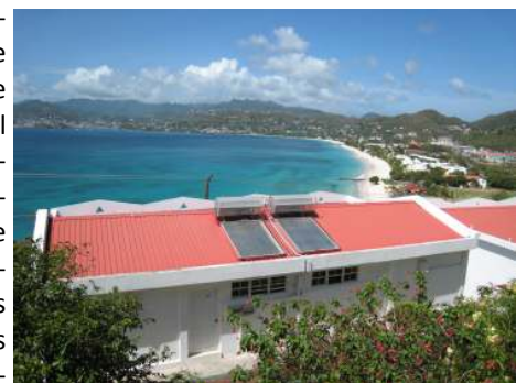
Un calentador solar de agua en un techo de St. George's. Sistemas como éste son comunes en Grenada.
